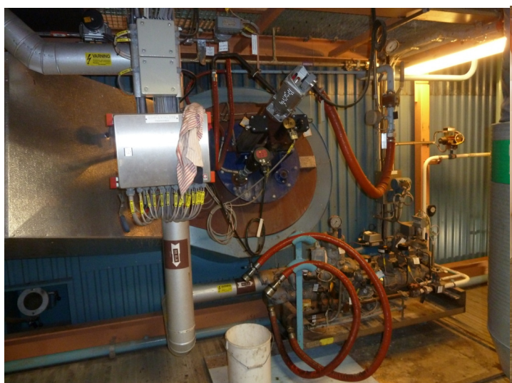
"Tändbrännaren" för den fluidiserade bädden.
