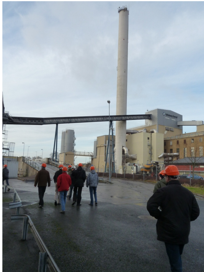
HP3 byggnaden sett mot VSV.
