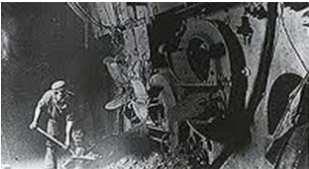
I ovan bild eldas det på i en av fyrarna och slaggas i nedre bild
