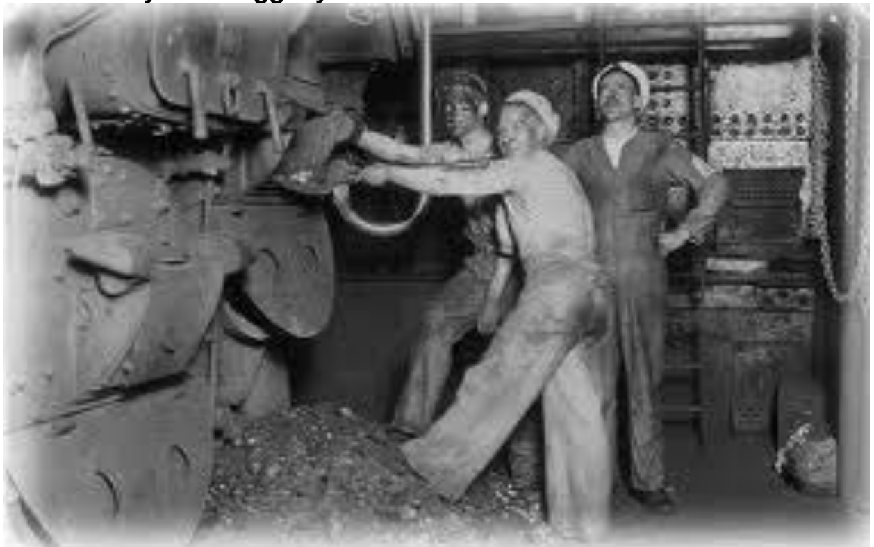
Maskinisten i vit uniformsmössa till höger, kollar med eldaren om det är för mycket slag i fyren.
