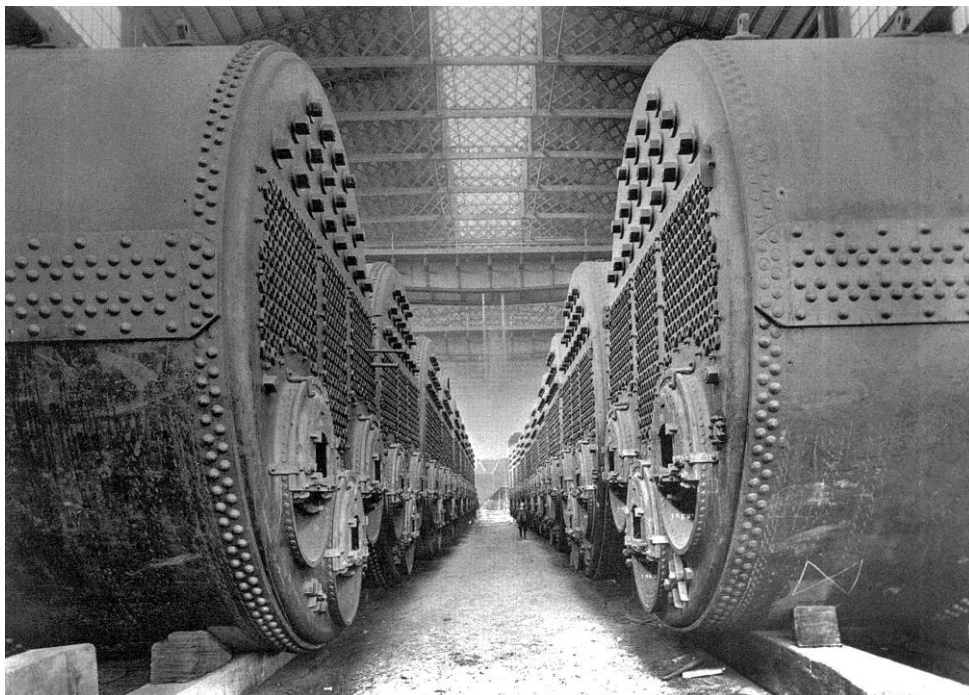
En del av tub pannorna färdiga för installation
