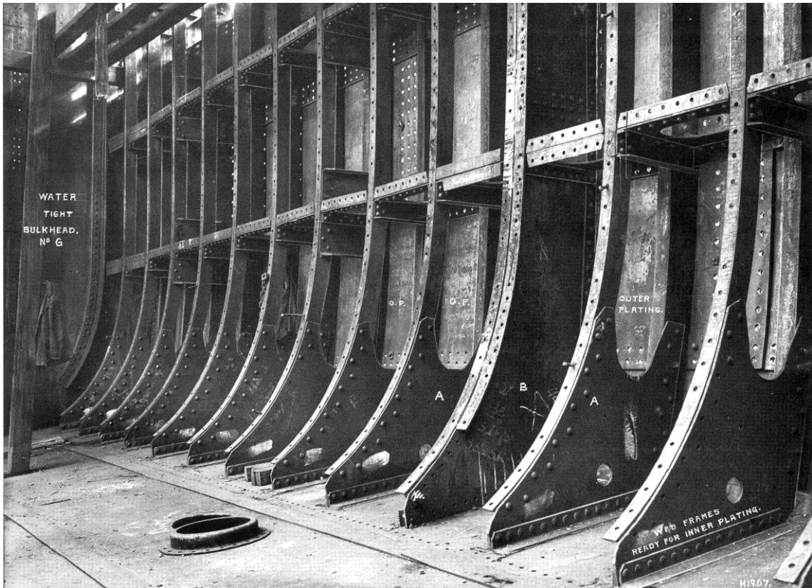
En detalj på skrovkonstruktionen. I botten syns ett av manhålen till dubbelbottentankarna.
