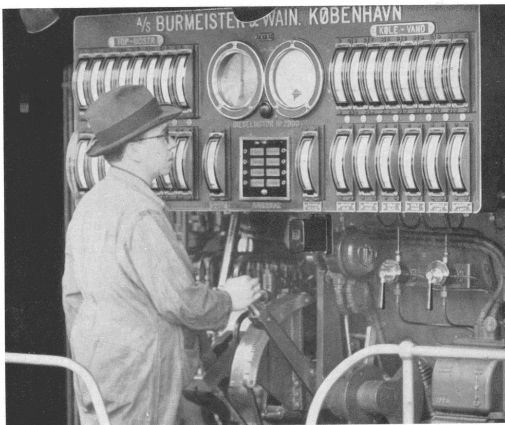
Manöverplattformen paa H. C. Ørstedværkets Dieselmotor.
