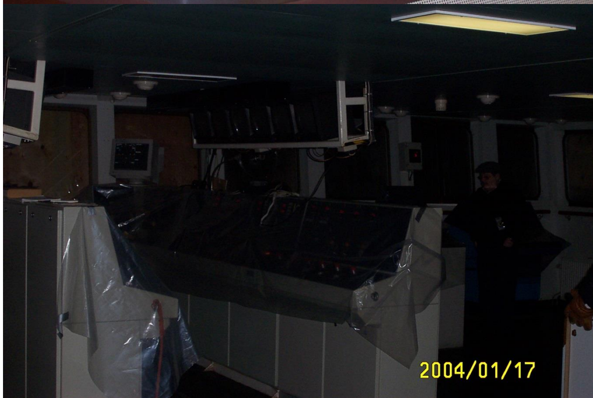
Bryggautomatiken var övertäckt och inplastad samt avfuktad
