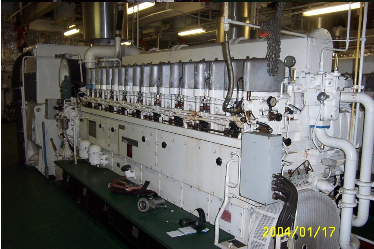
Några av huvudmaskinerna STORK Wärsilä F 240 på 9 cylindrar och utvecklar 2250 hp vid 100 r/m, Vid ett medeltryck av 7,8 bar och kolmedelhastigheten 8,7 m/sek. Cylinderdiam.240 mm och slaglängden 260 mm.
