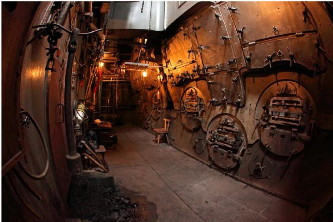
Till höger i bild ser Ni de två tubpannorna, försedda med tre eldstäder var och till vänster ser Ni kolboxarna
